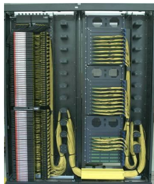
1920 vláken na 1 pasivní a 2 aktivní rozvaděče
