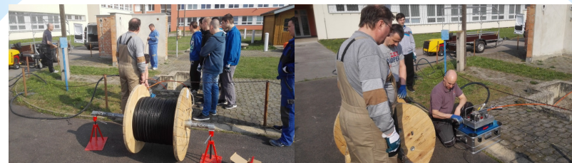
První fáze - zafukování optické kabelu na polygonu - duben 2017
